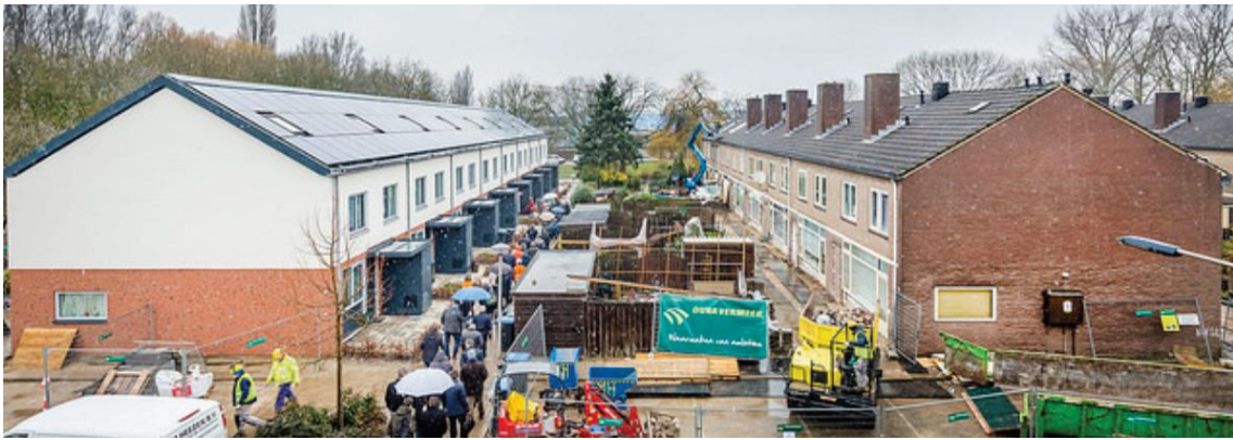
Obrázek 26: Komplexní renovace souboru rodinných domů v holandském Arnhemu prostřednictvím systému Energiesprong (2016).
