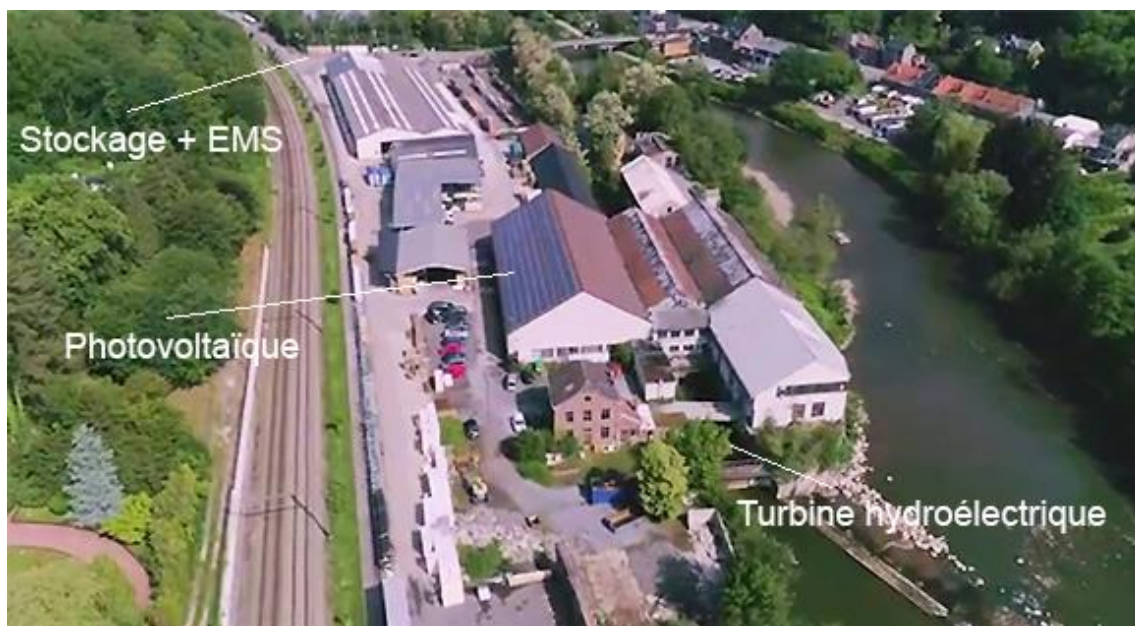
Obrázek 20: Průmyslová zóna, ve které je realizován pilotní projekt kolektivní samo-spotřeby Merygrid. Zdroj: http://renouvelle.be/fr/technologies/merygrid-un-micro-reseau-local-en-pilotage-intelligent
