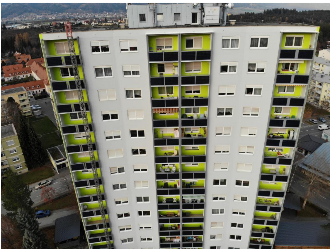
Obrázek 3: Realizace kolektivního FV systému na bytovém domě Europastrasse 64, Judenburg
