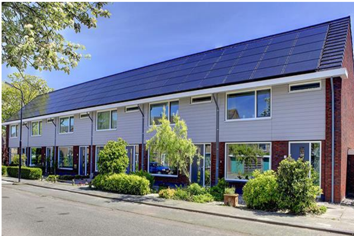
Obrázek 24: Realizace komplexní renovace souboru rodinných domů v holandském městě Heerhugowaard prostřednictvím systému Energiesprong (2014).
