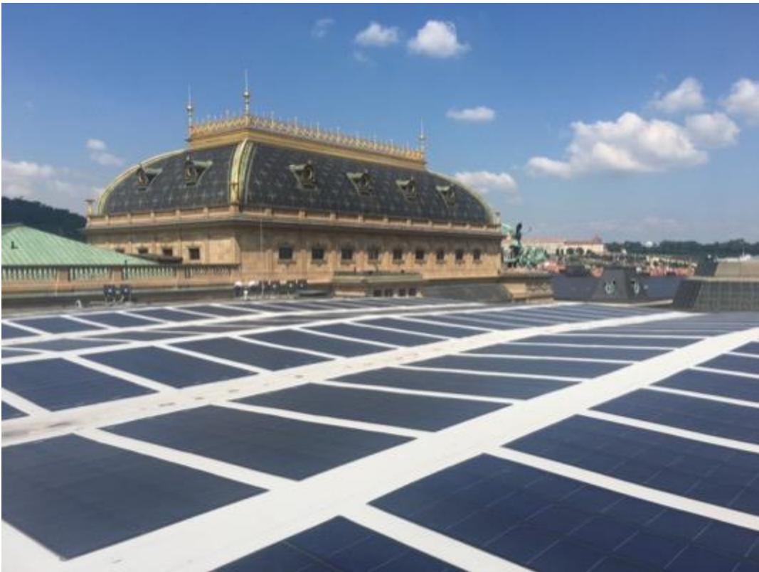
Obr 7: Fotovoltaika na Nové scéně ND (zdroj: hybrid.cz)
