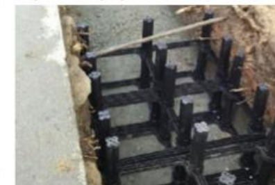
↑ Instalace prokořenitelných buněk, Praha 5, zdroj: Zahradní architektura Kurz, zdroj: foto Aleš Kurz
