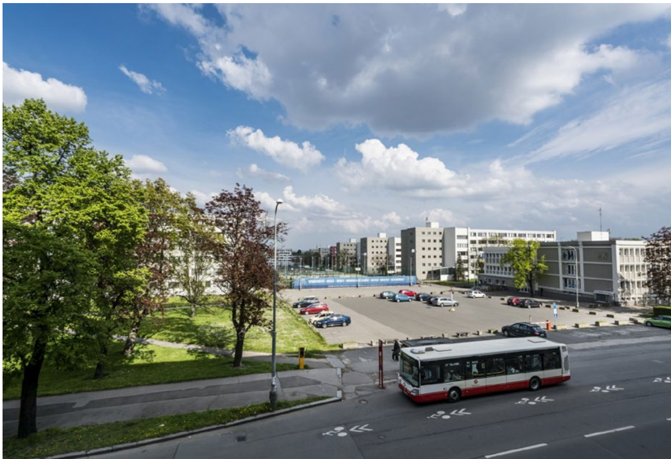
Koleje Strahov ČVUT jsou součástí největšího EPC projektu v Česku. Foto: ČEZ ESCO, a. s.
