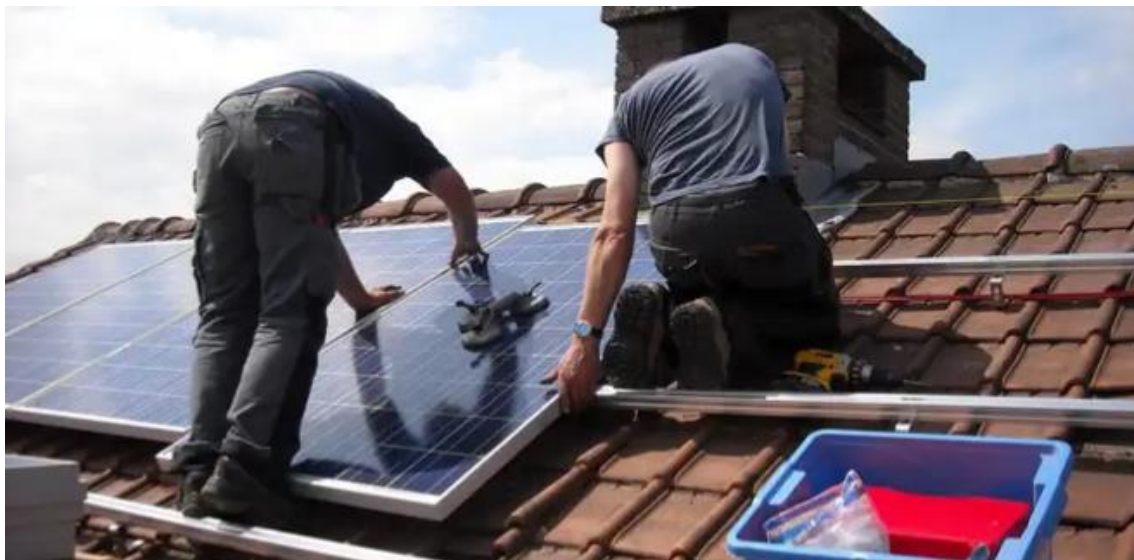
Obrázek 2 - Instalace střešní fotovoltaické elektrárny. Zdroj: Obnovitelně.cz
