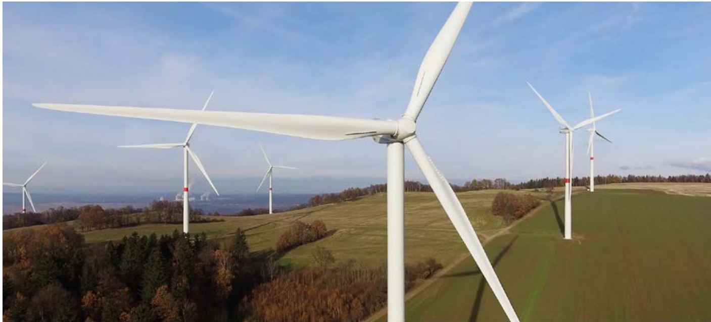
Větrný park ve Václavících. Zdroj: JRD Energo
