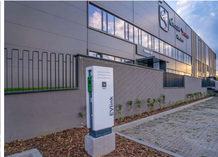
Kampus v Tachově počítá i s dobíjením elektromobilů. Zdroj: Urbanity
