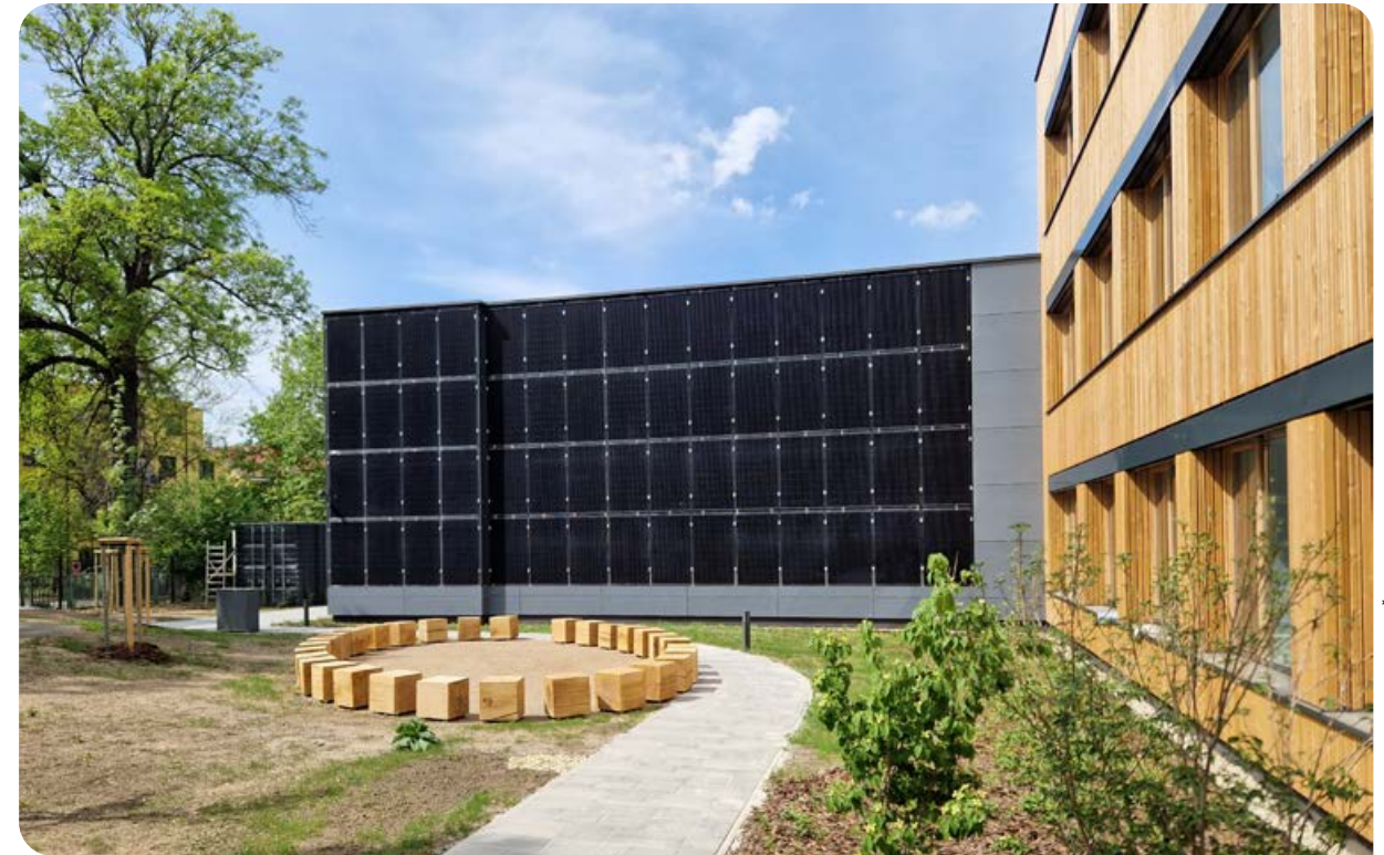
Renovovaná budova školy na Českobrodské v pasivním standardu a s fotovoltaickou fasádou. Zdroj: Magnas Media, s. r. o.
