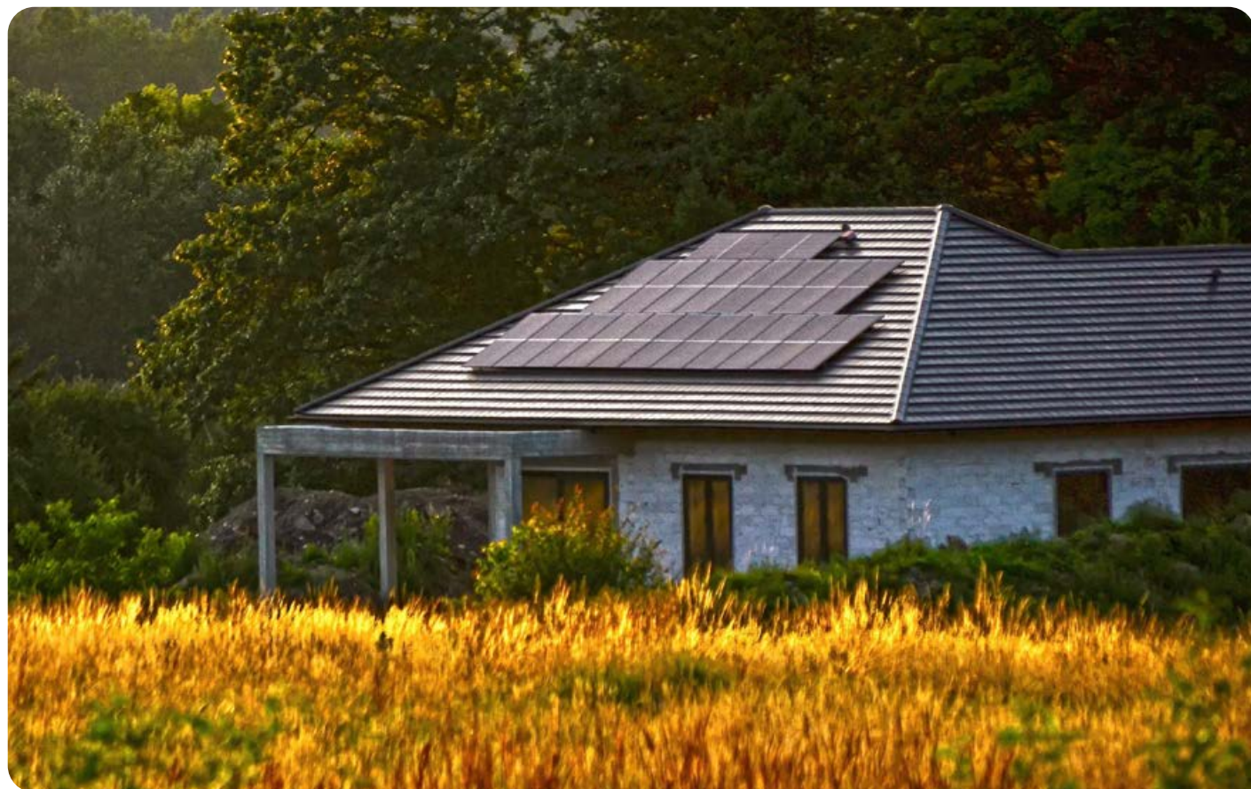
Dům se střešní fotovoltaickou elektrárnou. Takový pohled bude v Česku stále častější. Zdroj: pixabay.com
