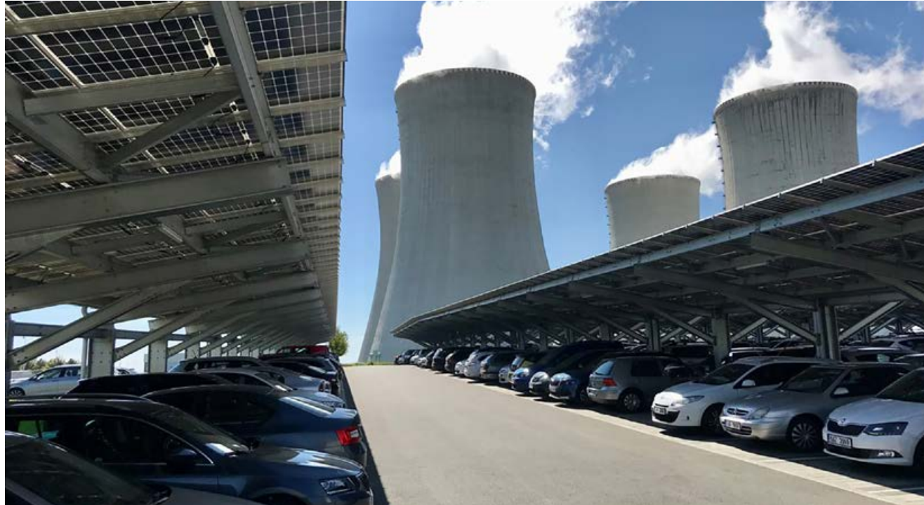
Carport napájený solární energií v Jaderné elektrárně Dukovany. Zdroj: ČEZ
