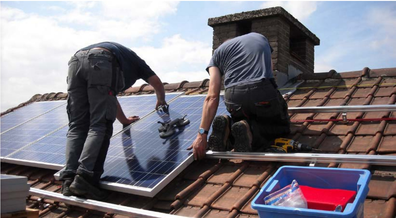
Instalace střešní fotovoltaické elektrárny. Zdroj: pixabay.com
