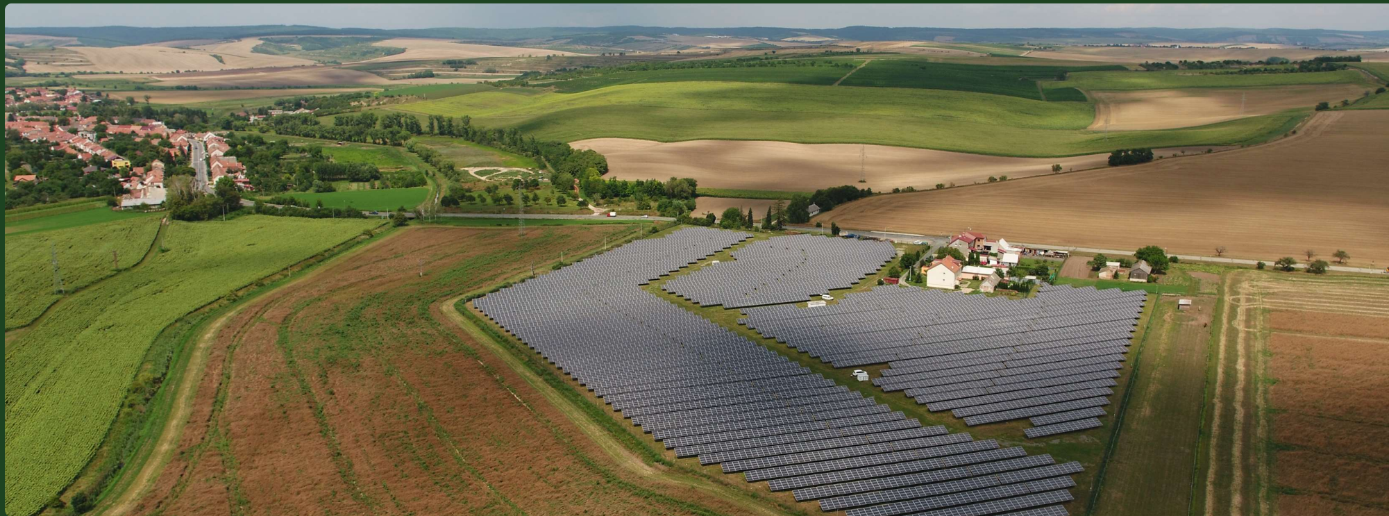
FVE KRUMVÍŘ 3,6 MW p
