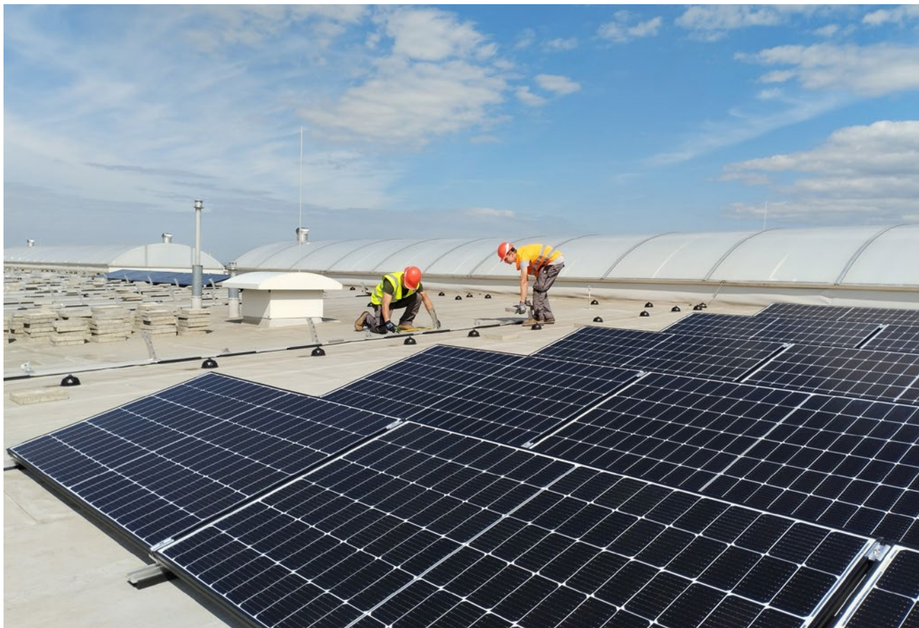
Důležité u plochých střech je nepodcenit statiku a zajistit panely proti odfouknutí. Zdroj: Solar Design
