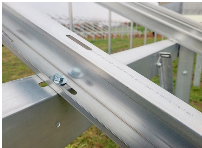
Ocelové profily pokrývá speciální antikorozní vrstva. Zdroj: Bragen
